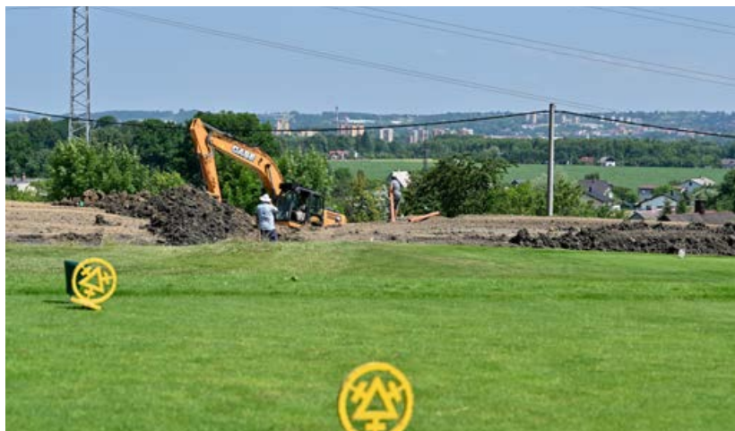
Pohled na stavbu třetí devítky z letošního léta Foto: Zdeněk Sluka
